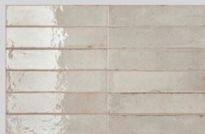
Muretos varandas em bloco de cimento revestidos a cerâmicos hidráulicos
