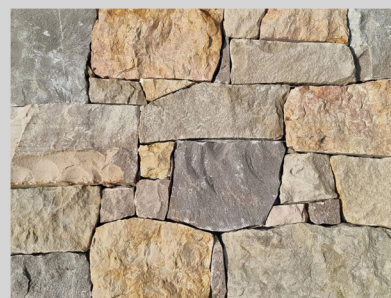
Muros vedação exterior em pedra natural
